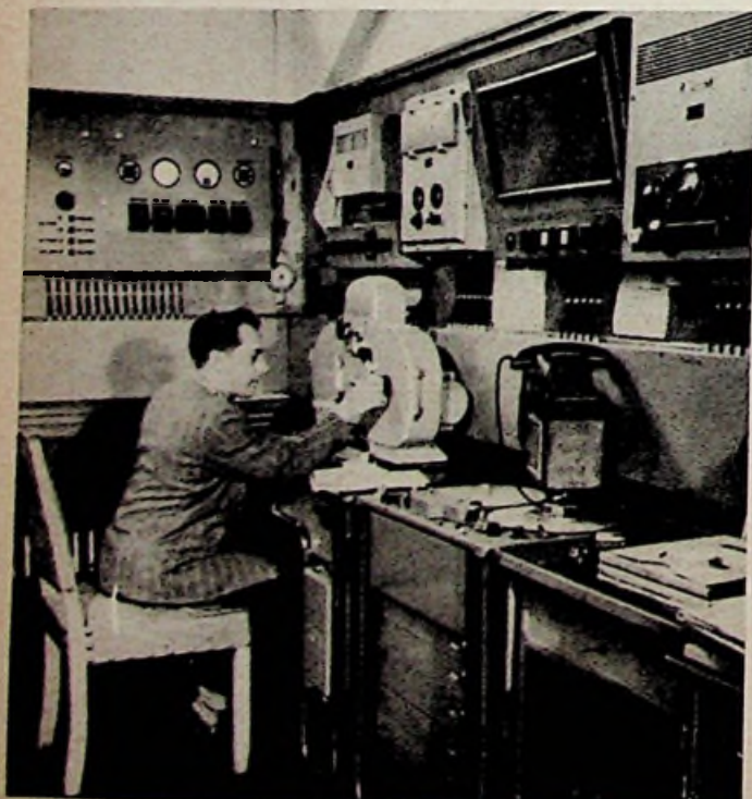
Klangfilm-Lichtton- und AEG-Magnetophon-Aufnahmegerät im Filmatelier
